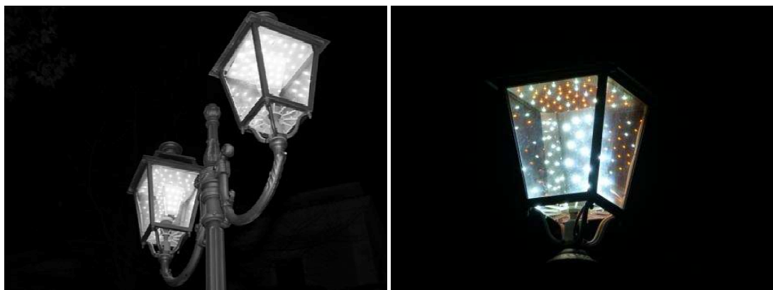
Figura 3 – Particolare di alcune lampade a led installate a Torraca, (Scarfone A., 2012).
